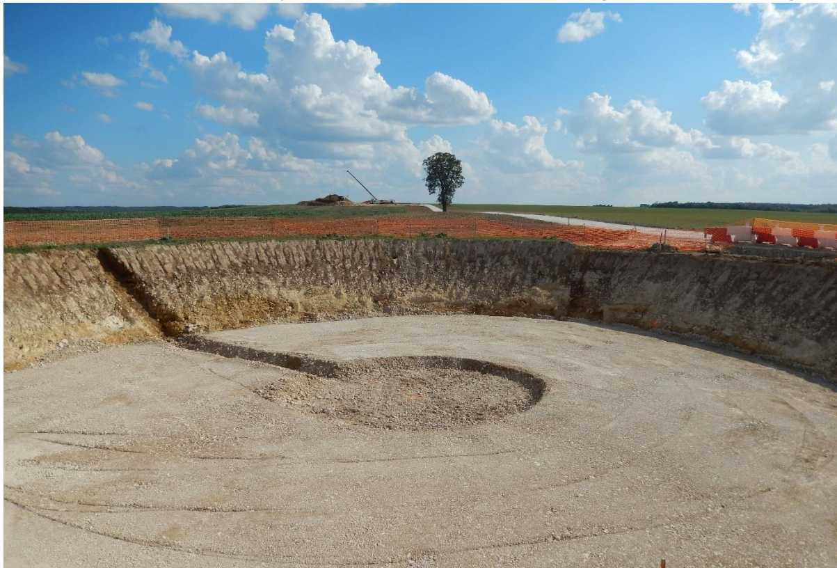
Excavation d'une fondation (préparation de l'assise et du passage des fourreaux en grave)
