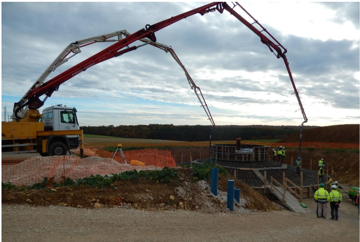
Fondation pendant le coulage du béton
