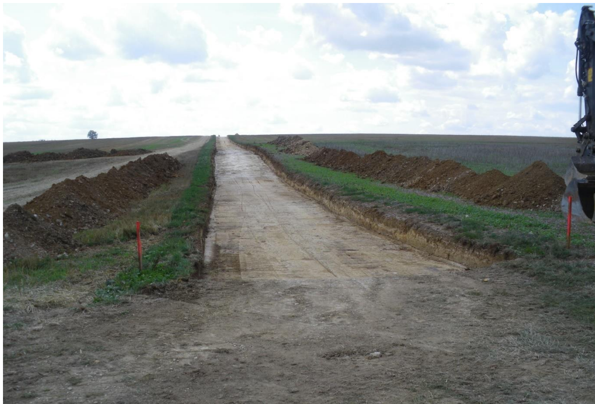
Excavation d'une fondation (préparation de l'assise et du passage des fourreaux en grave)
